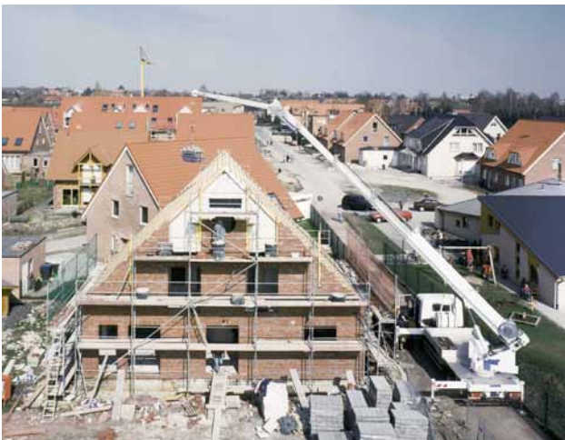
Abbildung 1 Das Stützsystem ist variabel und kann sich den Gegebenheiten vor Ort anpassen. Dadurch ergeben sich völlig asymmetrische Arbeitsbereiche, die durch eine ausgefeilte Sensorik berechnet und überwacht werden.
