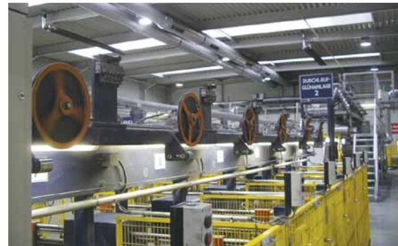
Abbildung 6: Wachendorff Geber sorgen für eine konstante Verweildauer in der Glühanlage.
