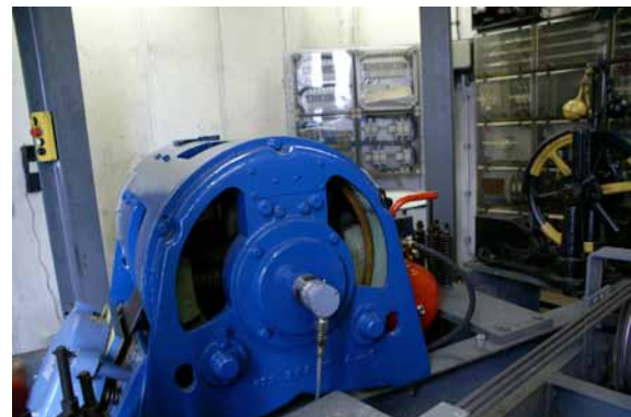
Abbildung 7 und 8 WDG/v.oben Maschinenraum: Der Drehgeber von Wachendorff Automation an seinem Einsatzort hoch über den Dächern der Stadt.
