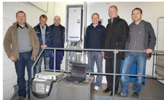
Abbildung 9 Team: Mitarbeiter von Otis, Emotron, Wachendorff Automation und den Stadtwerken haben das ungewöhnliche Projekt gemeinsam zum Erfolg geführt.
