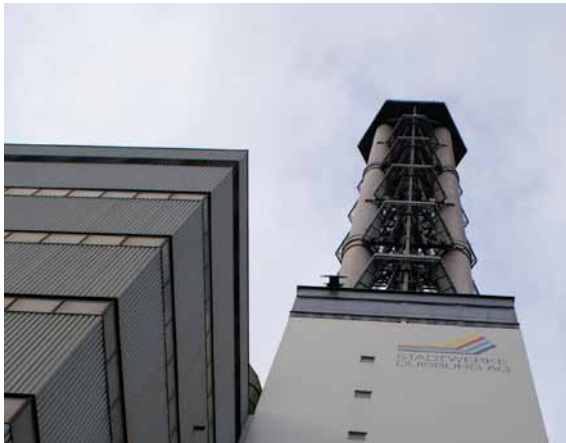
Abbildung 5 Wahrzeichen: Seit 1967 gilt der Turm als Wahrzeichen von Duisburg. Die drei Abgasröhren und die mittlere Aufzugsröhre bilden einen markanten Blickfang, wenn sie in der Nacht mit grünem Licht beleuchtet werden.
